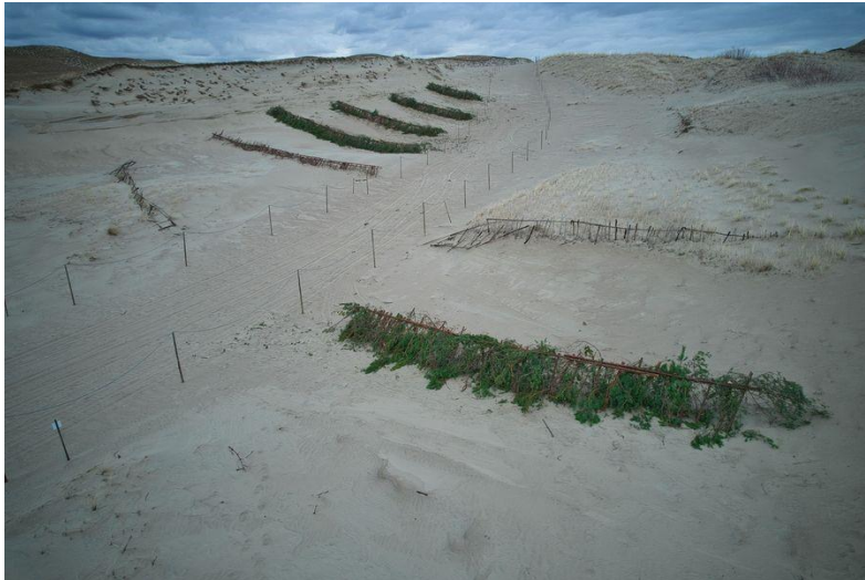
4.3 pav. Įrengtos smėlio gaudyklės
