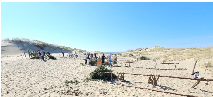
4.1 pav. Parengiamieji darbai prieš įrengiant smėlio gaudyklės
