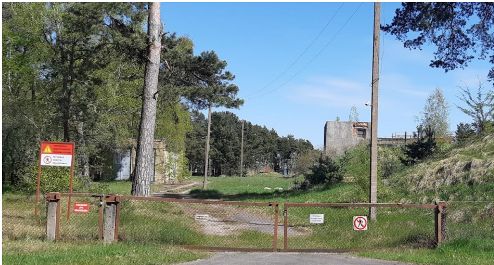
3.4, 3.5, 3.6 pav. Senieji Preilos – Pervalkos valymo įrenginiai (siurblinė, chloratorinė, kt. kiemo statiniai), Preilos g. 1B, Neringa
