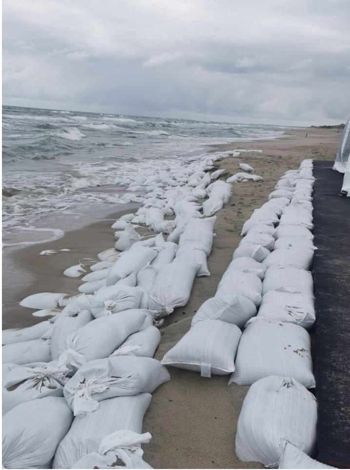
6.3 pav. Smėliu pripildyti maišai, naudoti apsaugai nuo inventoriaus nuplovimo
