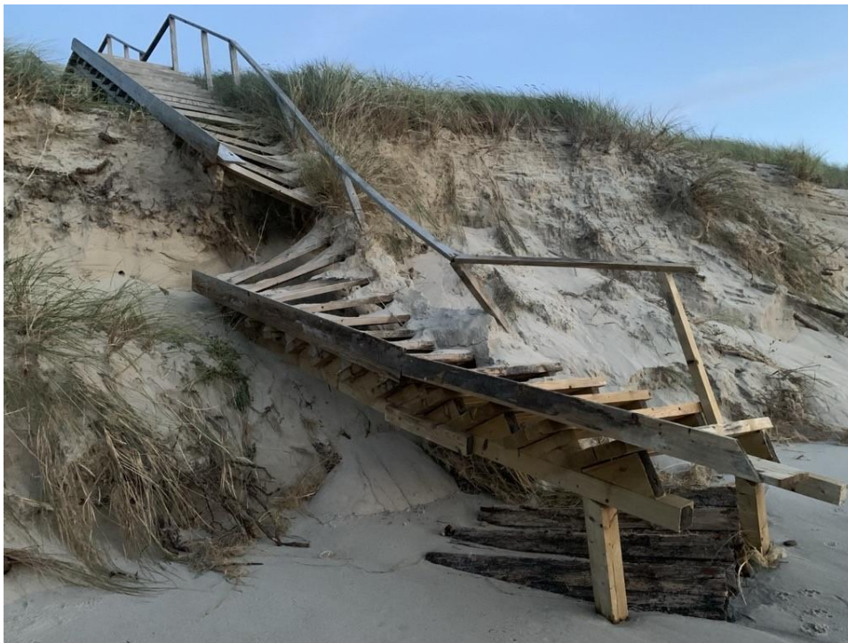
6.5 pav. Audros apgadinti laiptai per apsauginį kopagūbrį.
