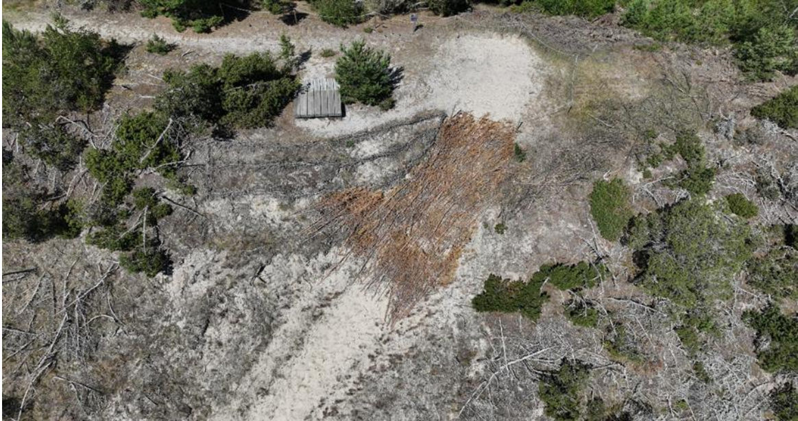
3.20 pav. Žabtvočių sutvirtinimai.
