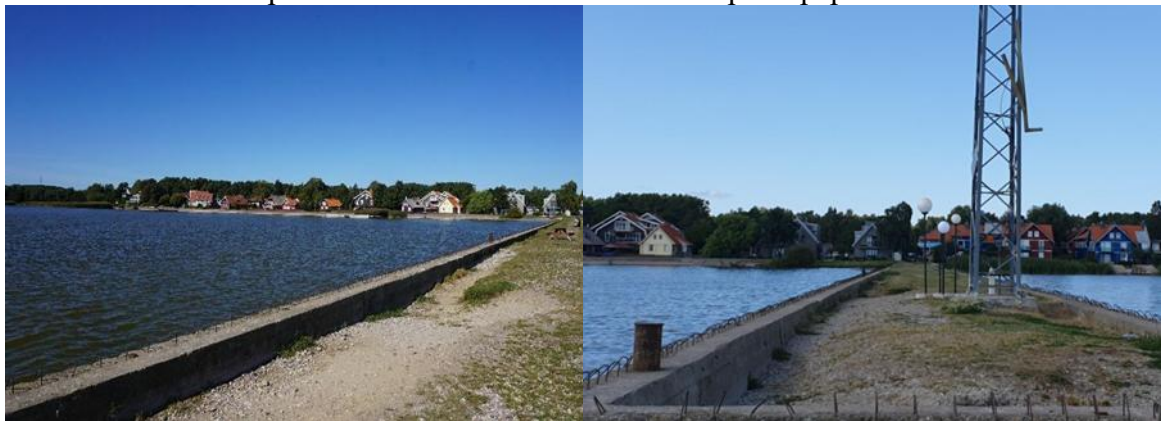
1.3, 1.4 pav. Pervalkos pirsas prieš remontą.
