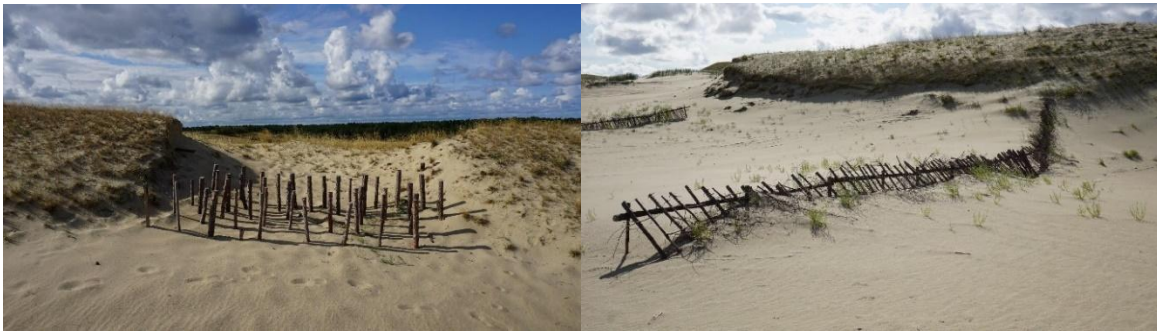
6 pav. Smėlio gaudyklės – medinių smaigų (kairėje pusėje) ir burės tipo (dešinėje pusėje).
