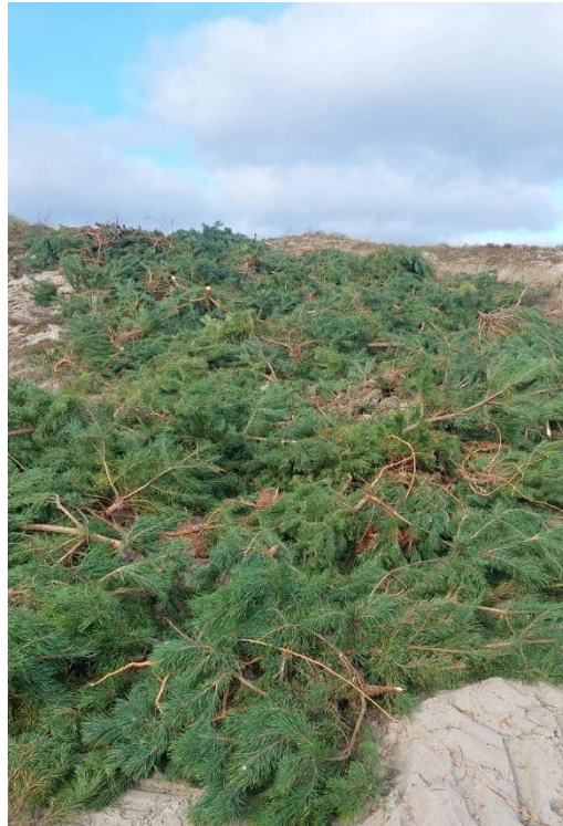
2 pav. Vakarinis apsauginio kopagūbrio uždengimas pušelėmis
