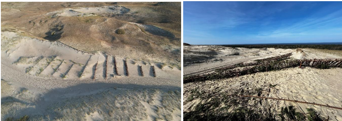
7 pav. Smėlio gaudyklių įrengimas 2024 m.
