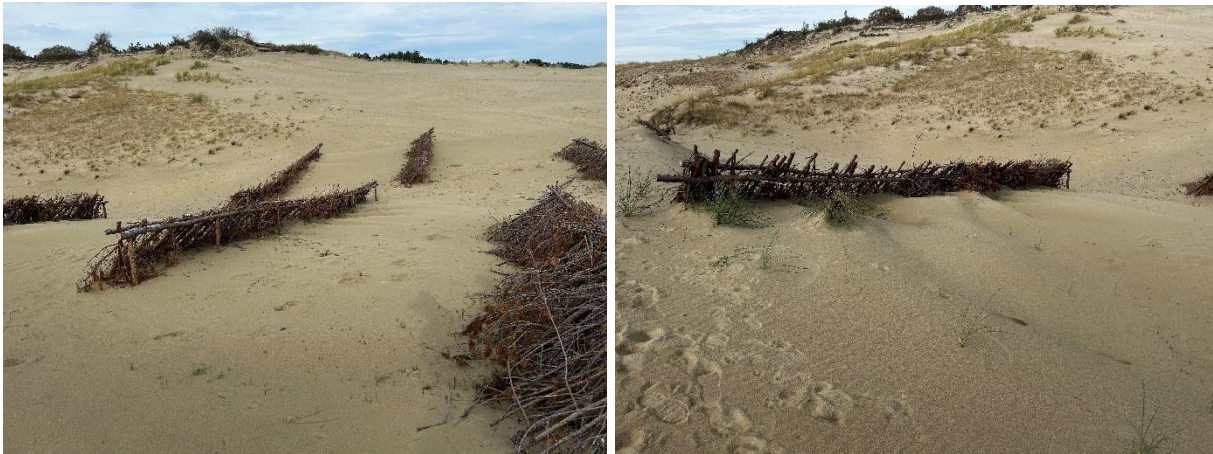
8 pav. Smėlio gaudyklių statymas Parnidžio kopoje.
