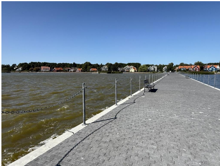
3.12 pav. Pervalkos pirsas po remonto.
