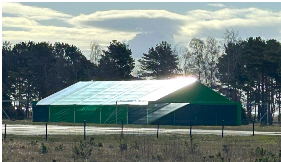
1.1 pav. 2025 metais atsiradęs tentinis angaras.
