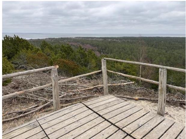
7.17 pav. Sulūžę turėklai.
