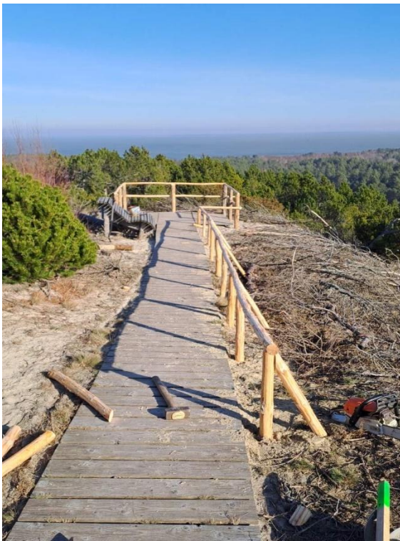
7.18 pav. Atnaujinti turėklai.
