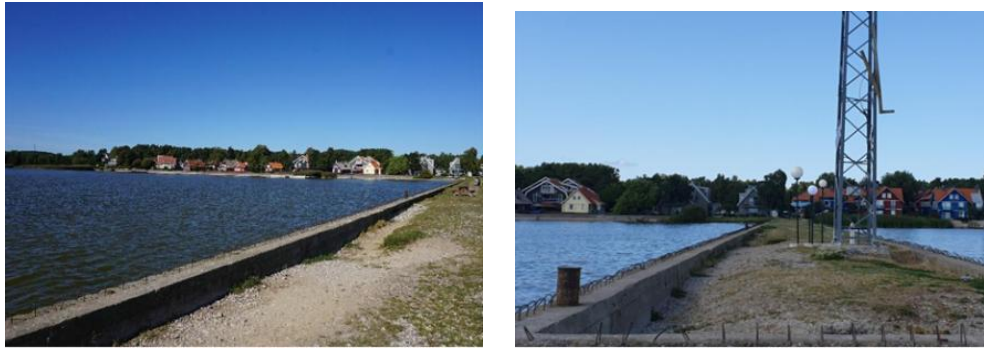
3.11 pav. Pervalkos pirsas prieš remontą.
